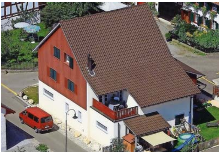
Dieses Haus dient als Referenzanlage. Aufnahme vor dem Umbau.
