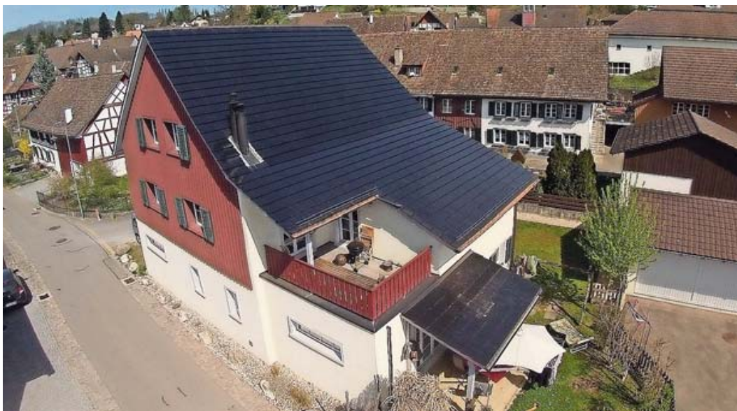
1500 Solardachziegel decken nun das Haus an der Friedhofstrasse in Glattfelden.
